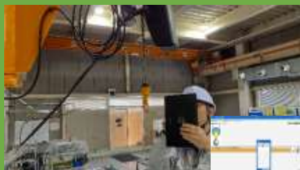
タブレットで設備点検
